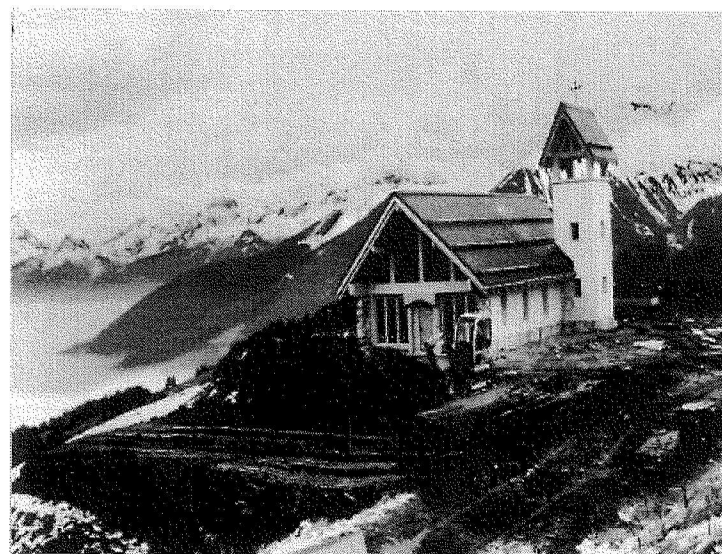
Avancement des travaux à la fin de l'automne 1996. Les aménagements extérieurs sont en cours. On distingue la mer de brouillard sur la plaine du Rhône.
